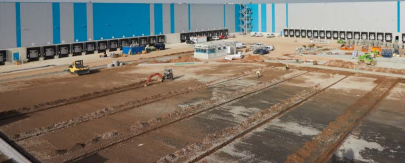
Großbaustelle mit ausgeklügeltem Infektionsschutz: das Logistikzentrum in Lich.
